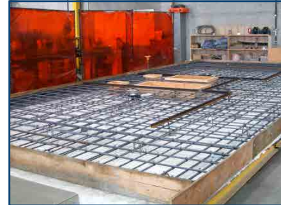
3 | Engineered Rebar Mat ready for Concrete Pour
