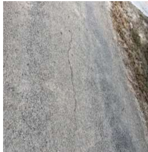
Longitudinal cracks
