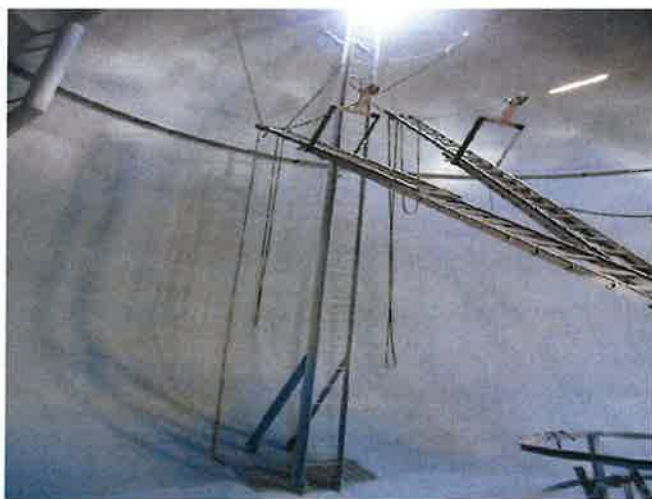
ZINC PRIMER APPLICATION
