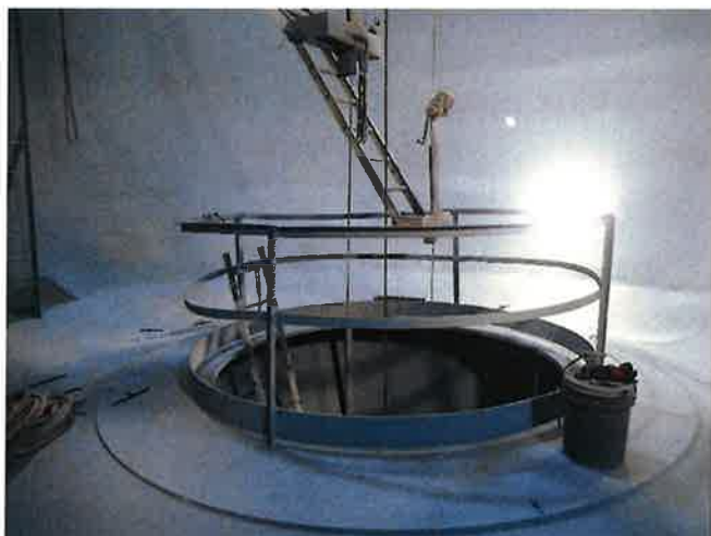
ZINC PRIMER APPLICATION
