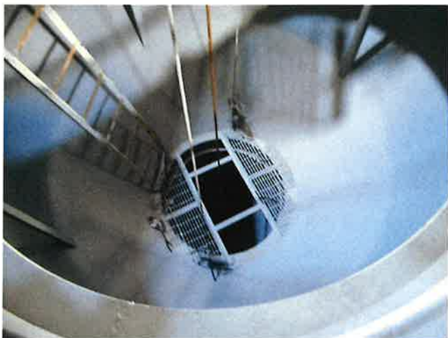
ZINC PRIMER APPLICATION
