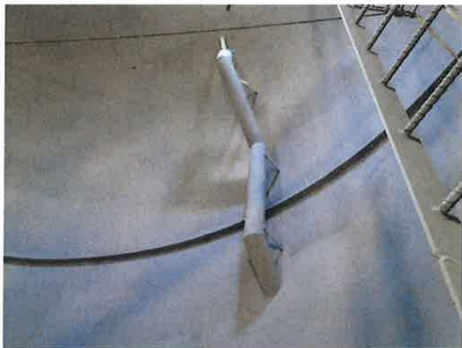
ZINC PRIMER APPLICATION
