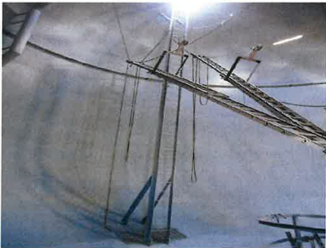
ZINC PRIMER APPLICATION
