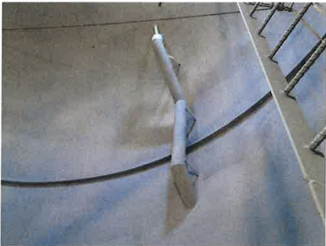
ZINC PRIMER APPLICATION
