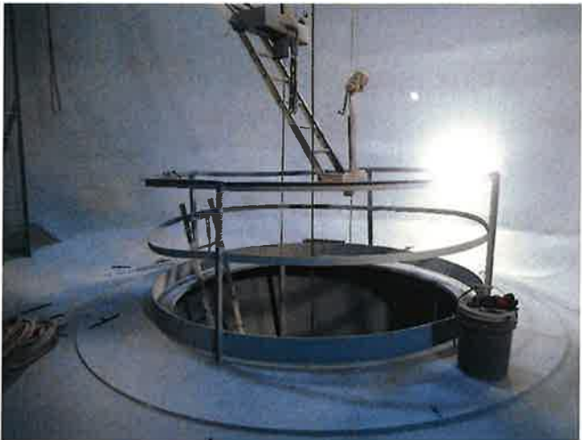
ZINC PRIMER APPLICATION
