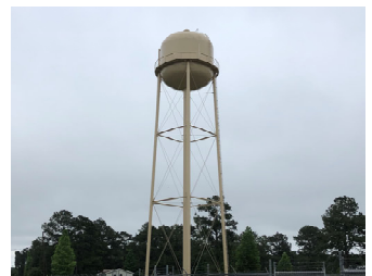
New EST – Tarkington SUD.
