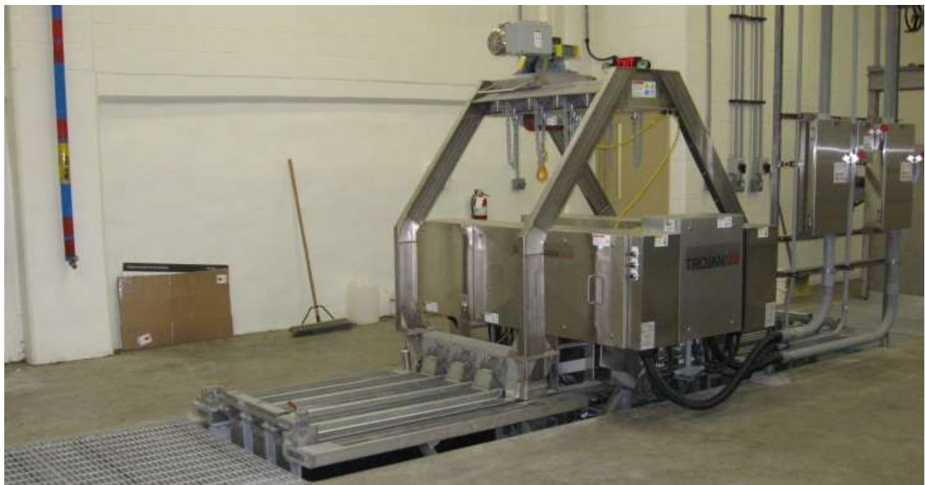
Trojan 4000 UV Disinfection System – Fond du Lac WTRRF.
