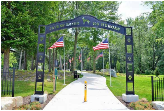
Entrance arch 14'L x 12'H steel frame
