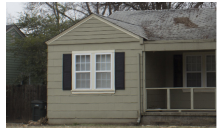
Asbestos siding
