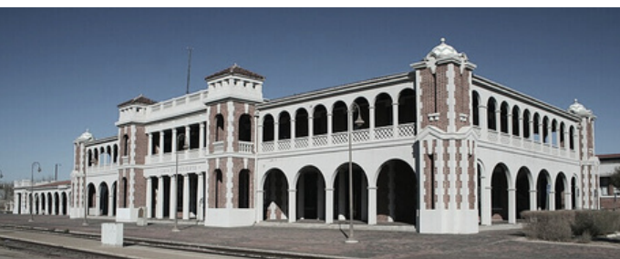
Harvey House Barstow Casa del Desierto
