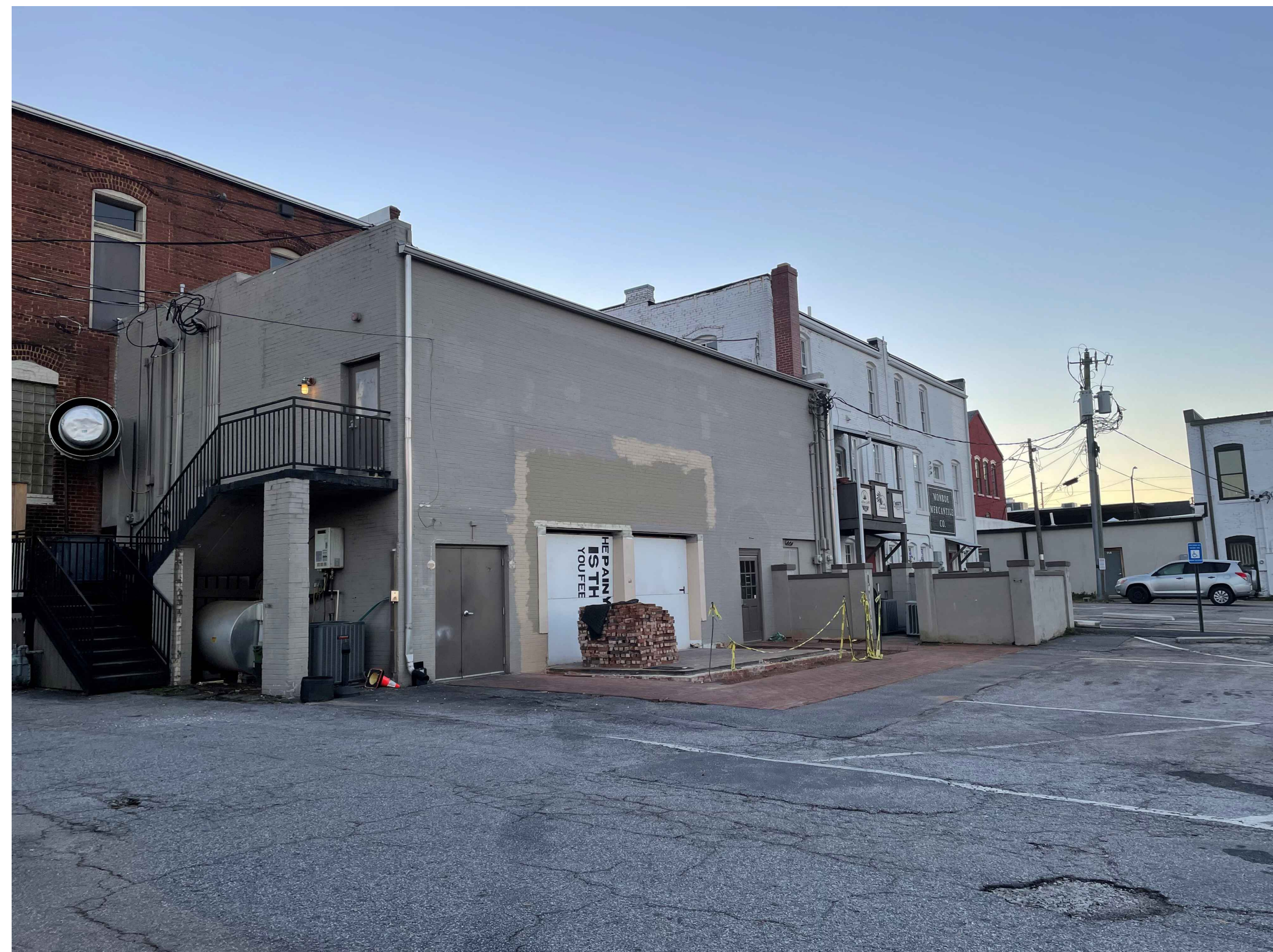
EXISTING CONDITIONS N.T.S.
