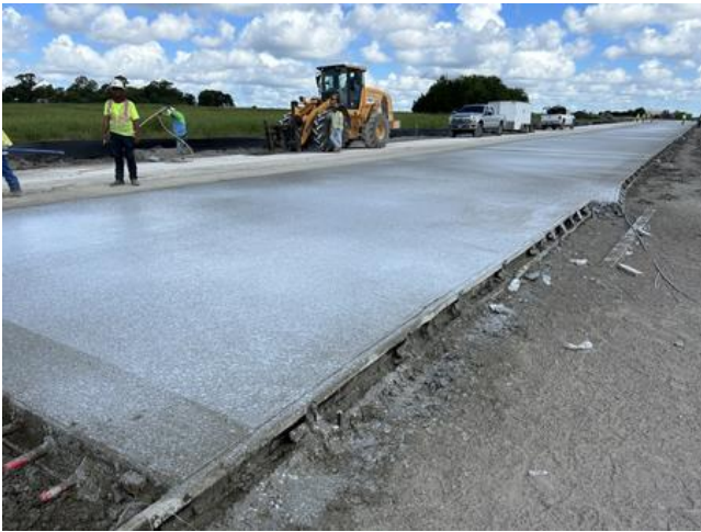
August 15, 2024 Pavement Pour
