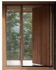
FRONT DOOR : TYPE: WOOD PIVOT DOOR
