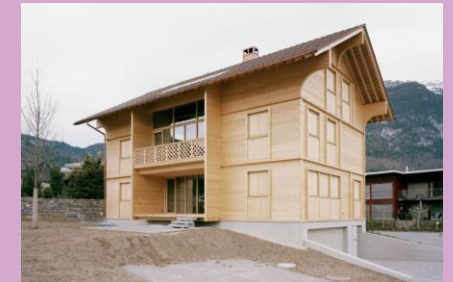
House K Seilerlinhart
