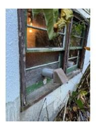
Figure 1-8. Rotten Window Sill.
