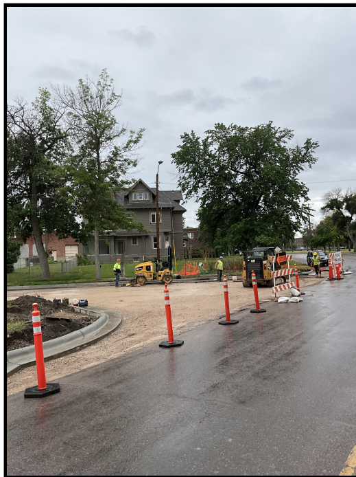
Park Dr. N. & 3rd Ave N. - Base Course Prep
