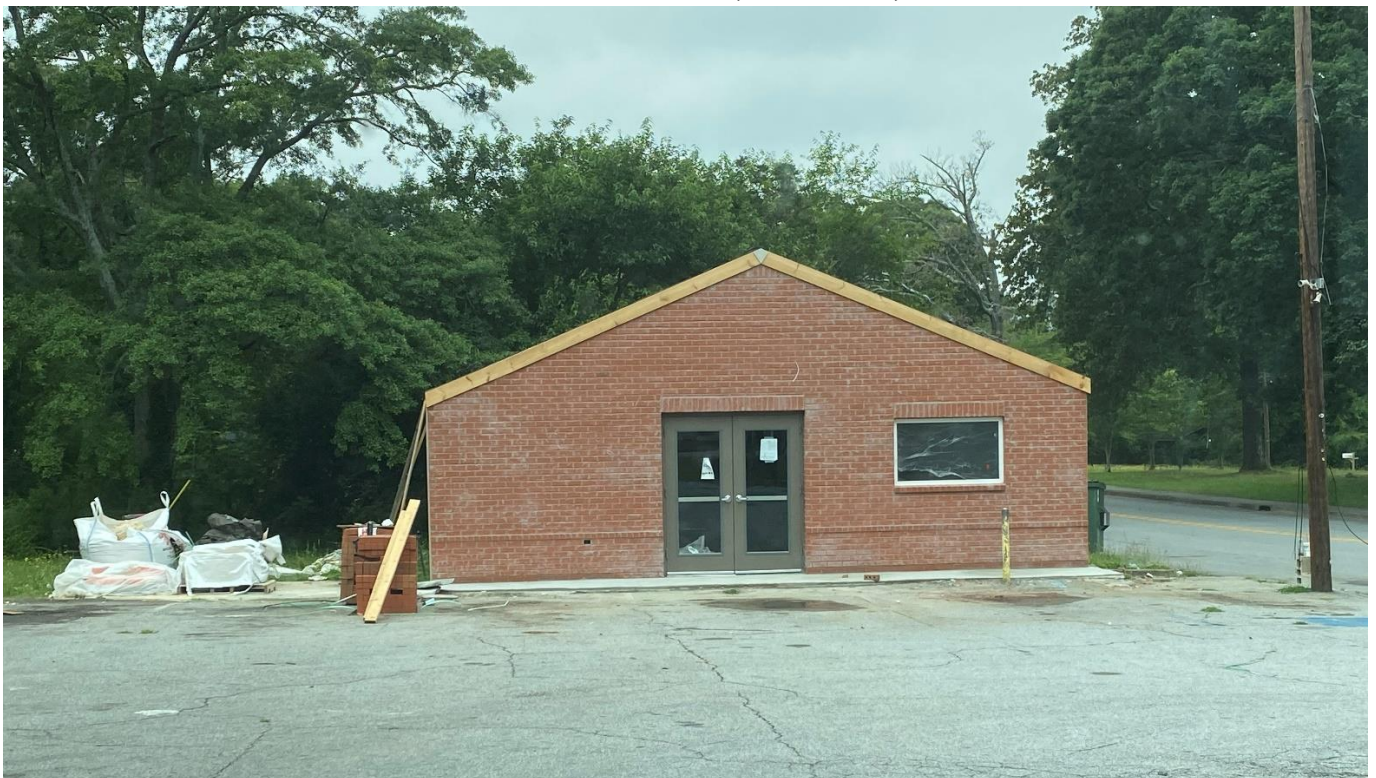
FRONT FAÇADE (JUNE 2023)
