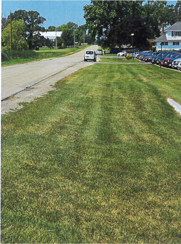
▲ 5 – Bennett’s Auto Ditch/Culvert
