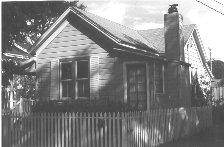
F. Maggi / Nov. 1999 / View from street
