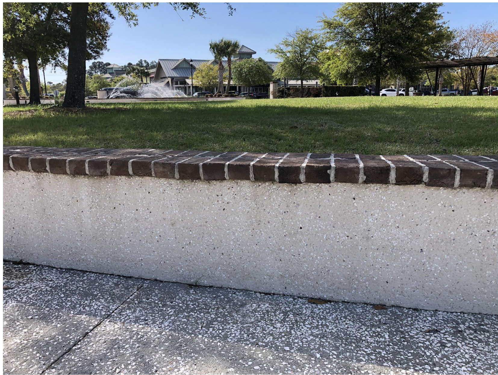
5 // L600 TABBY WALL WITH BRICK CAP SCALE: N.T.S.
