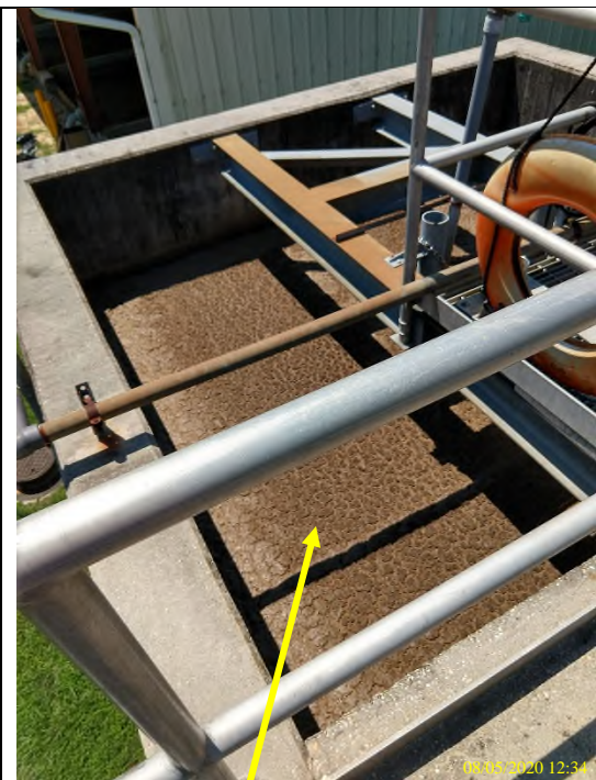
17. Aerobic Digester
