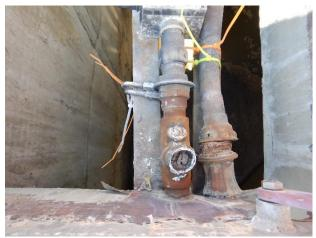
Corroded instrumentation conduit
