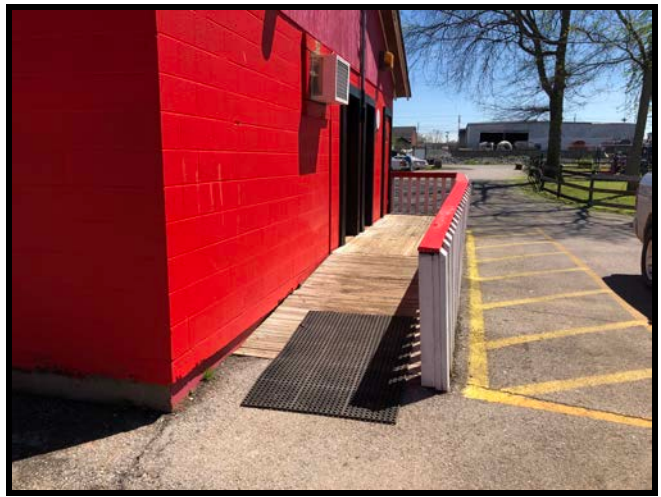
J.W. Johns Jr. Restroom Ramp Slope
