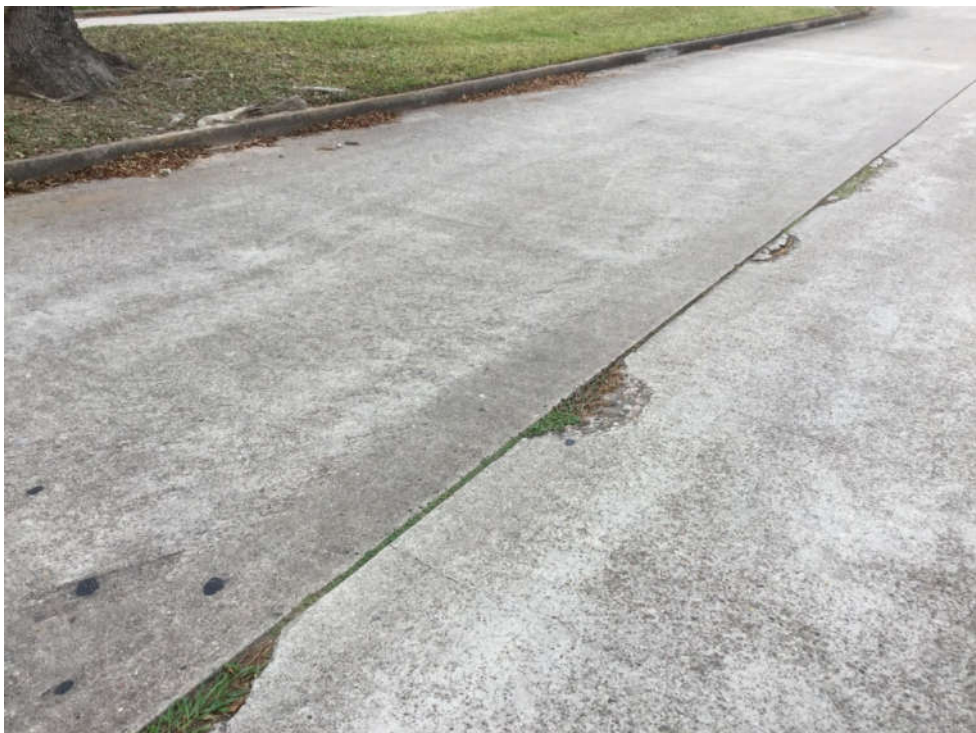
SPALLING
