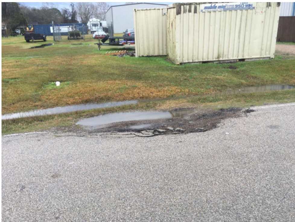
EDGE CRACKING
