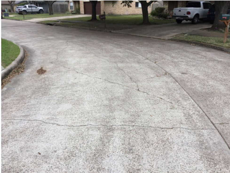
LONGITUDINAL CRACKING
